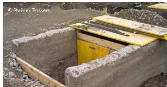
© Rainer Possert Luftschutzdeckgang verbaut (Denkmalschutz) Gesamtansicht auf S 42f, grüne Markierung.
